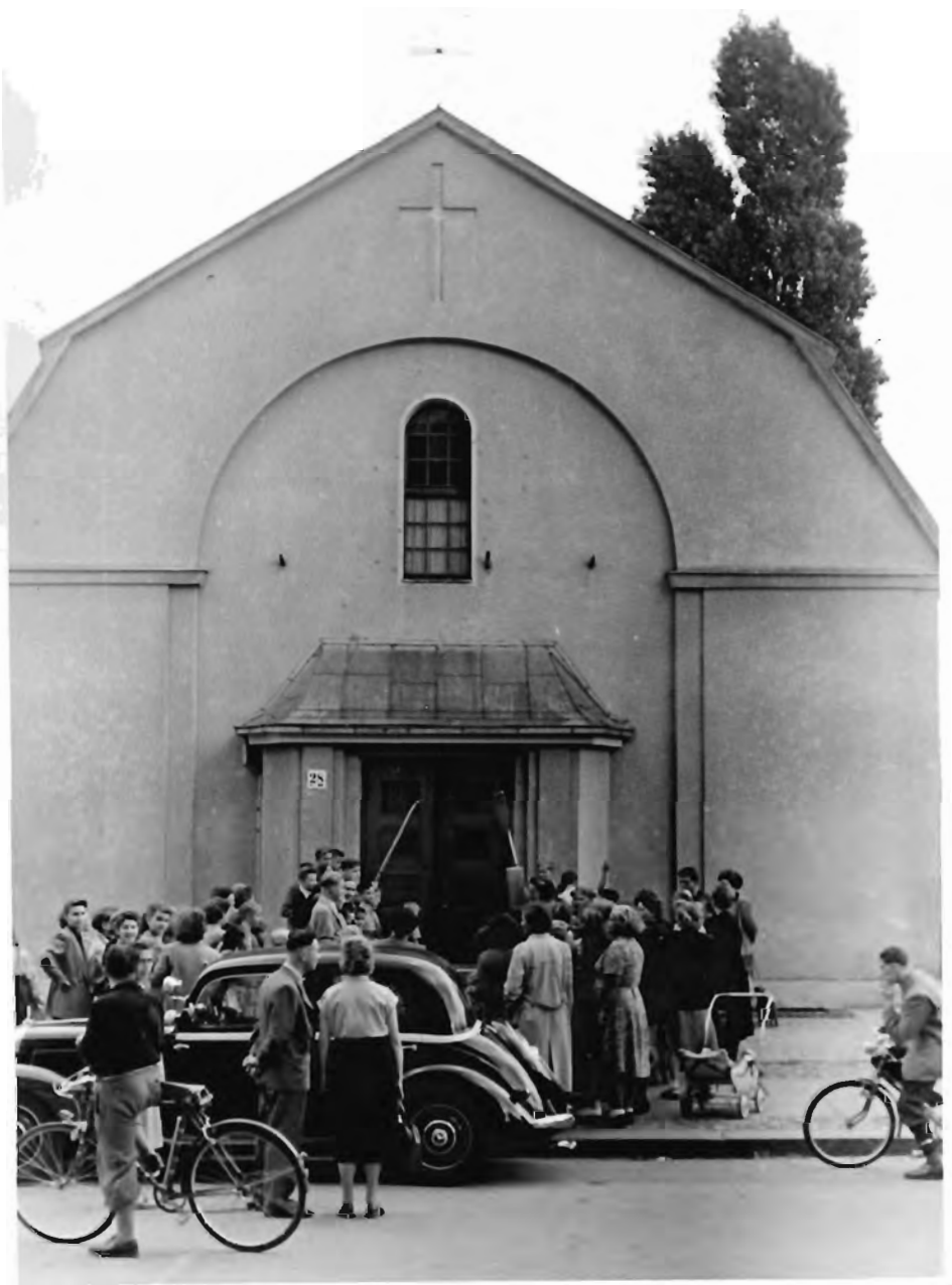
Ölberg-Kirche, damaliger Haupteingang Lausitzer Straße, wahrscheinlich Wiedereinweihung 1950
